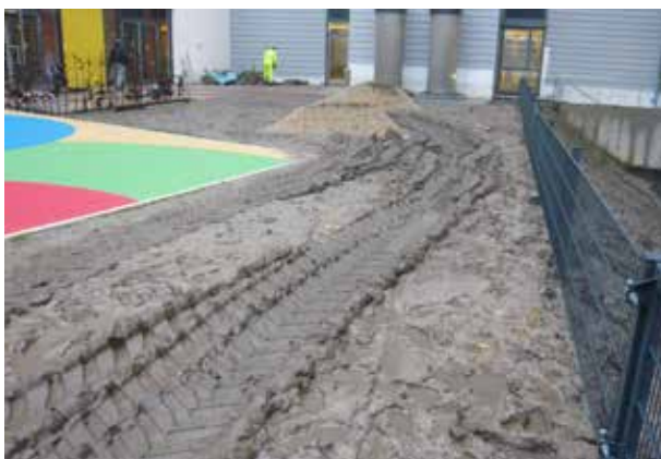
Abbildung 4.2: Verdichteter Boden (THIEME-HACK).
