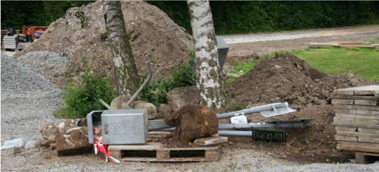
Abbildung 4.12: Durch Baumschutz vermeidbare Schäden an Stamm- und Wurzelbereich (THIEME-HACK.)
