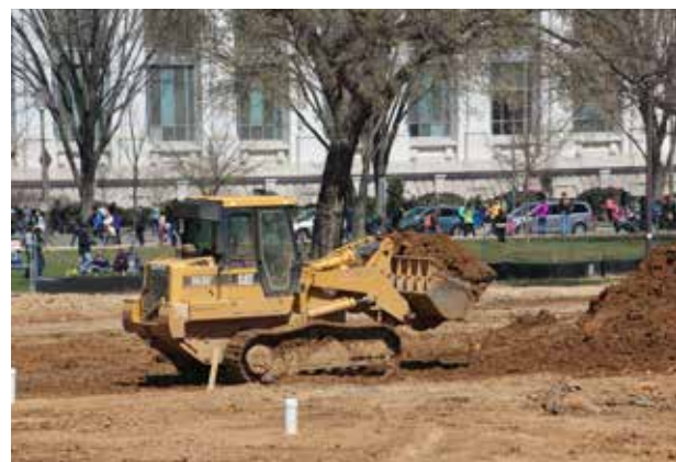
Abbildung 4.3: Baubegleitender Bodenschutz (THIEME-HACK).
