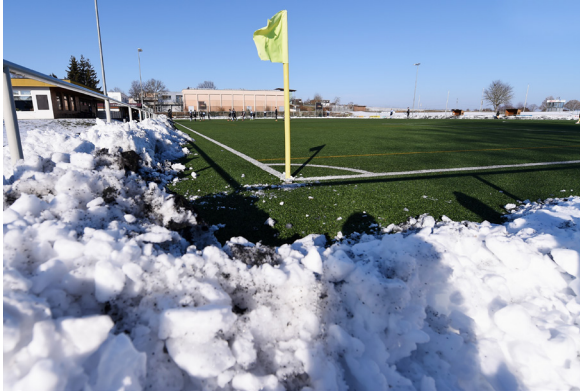
Abb. 3: Austrag von Kunststoff-Füllstoff durch Schneeschieben (© picture alliance)
