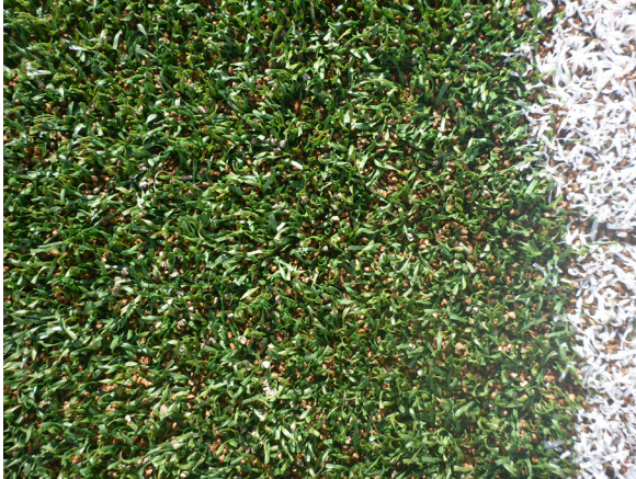
Abb. 2: Kunststoffrasen-Spielfeld mit Kork-Sand-Füllstoff (Quelle: Jutta Katthage/BISp)
