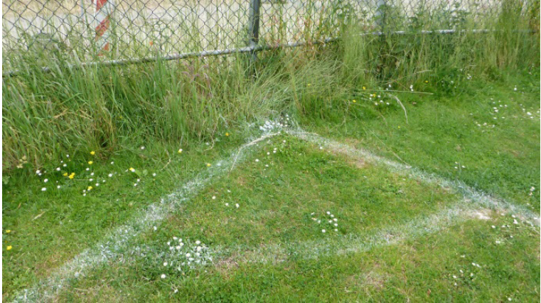
Unterschreitung des Sicherheitsabstands und des hindernisfreien Abstands (vgl. DIN 18035, Teil 1)
