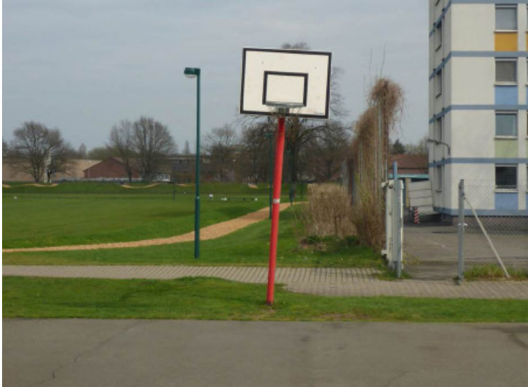
Schiefe Streetball-Anlage. Hier kann die Standsicherheit gemindert sein.
