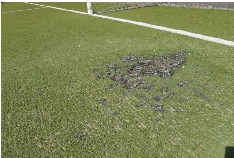
Verschlissener Belag im Torraum
