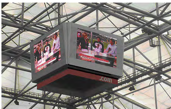
In den Videowürfel können sowohl HF 26 - als auch Ü-Wagenausgangs- als auch FAN-TV Signale eingespeist werden. Die Dachkonstruktion, mit der Öffnungsmöglichkeit, erlaubt die Aufhängung eines solchen Videowürfels über dem Spielfeldmittelpunkt. Im Hintergrund ist der Catwalk mit Lautsprechern zu erkennen Abb. 56: Videowürfel (Arena auf Schalke)
