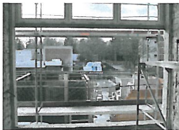
Blick von Trakt A auf die Baustelle
