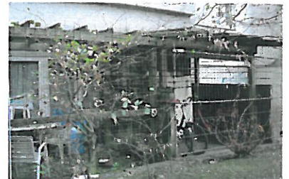
Auf den Tiefgaragendecks, die öffentlich für jedermann zugänglich waren, hatten die Bewohner ihre Terrassen aus Angst verriegelt. Die selbst gebauten Dachkonstruktionen sollten gegen heruntergeworfene Gegenstände schützen.
