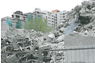
Während die Westflügel der Hochhausriegel abgerissen wurden, begann parallel schon die Sanierung der stehen bleibenden Gebäude.
