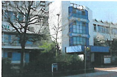
Das ehemalige Zentrum war nahezu vollkommen verfallen: der Supermarkt in der 1. Etage hatte dicht gemacht und mit ihm die anderen Praxen und kleinen Läden auch.
